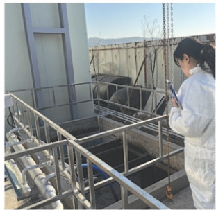
위 하수관로 준설 현장, 아래 가축분뇨배출시설 준공검사.
